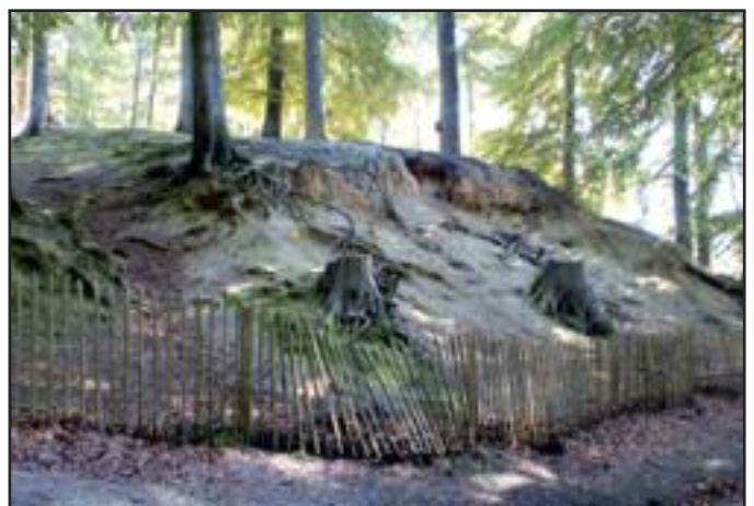
La zone apparaissant sur la photo de gauche étant à présent entièrement clôturée, des promeneurs aggravent l’érosion sur le flanc opposé, malgré la clôture (© Michel MAZIERES)
